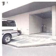
1階各室からパーキングスペースに直接出入りできる機能的な設計です。荷物の搬入出にも便利です。
